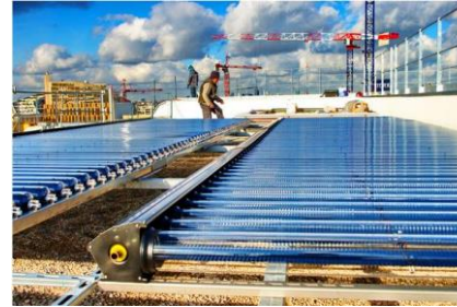
Capteur à tubes sous vide
