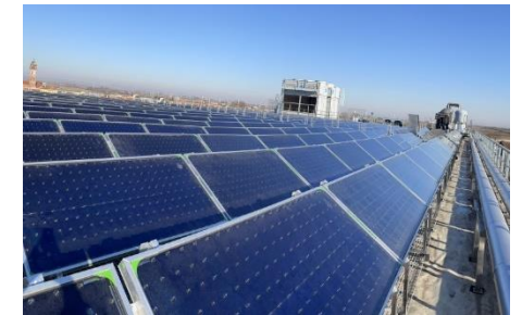
Capteur plan vitré sous vide
